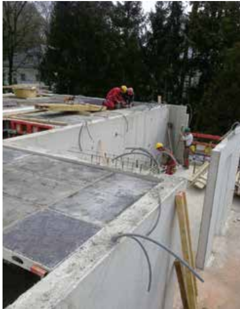
Betonierte unbewehrte Wände, Wohnanlage Wolfratshausenerstraße in München.
