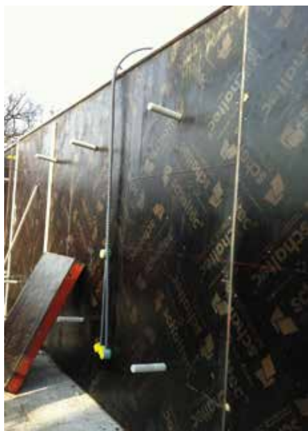
Eine unbewehrte Wand vor dem Zuschalen, Wohnanlage Wolfratshausenstraße in München.
