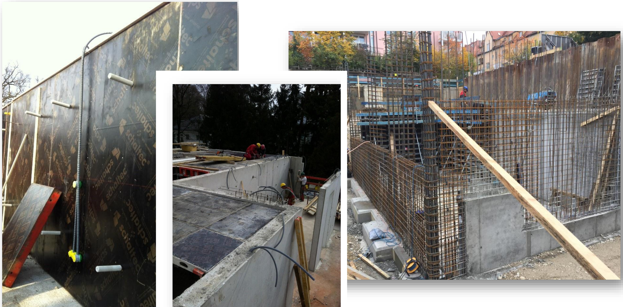
Bild 7+8+ 9, unbewehrte Wand vorm Zuschalen, betonierte Wand, bewehrte Wand
