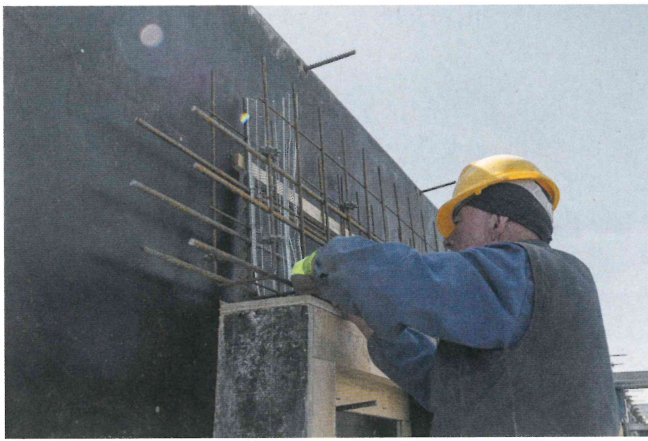
Bild 8 Konstruktive Bewehrung über Fensteröffnung Außenwand im 5. OG
