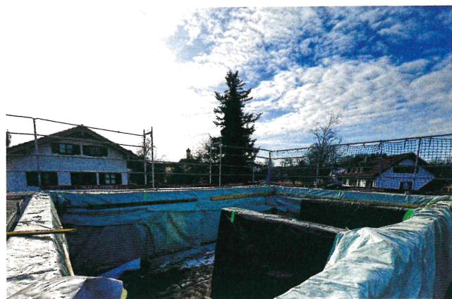
Bild 6 Fachgerechte Abdeckung von Lehm-mauerwerk im Bauzustand
