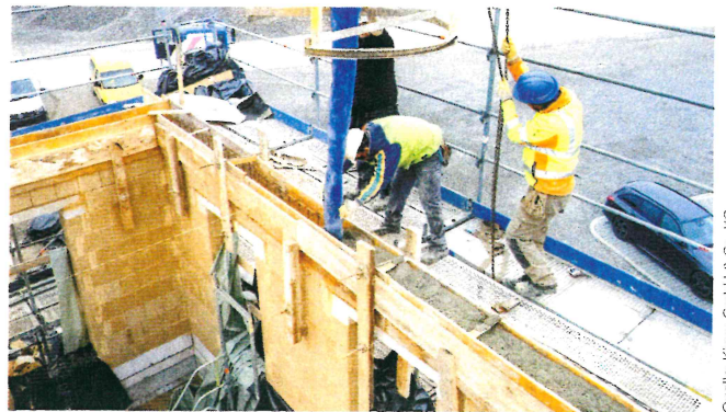
Bild 4 Ringanker als U-Schale mit Beton vergossen
